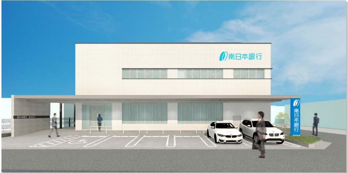
▲外観：正面庇の大型化、通用口庇の設置により、雨天時のお客さまの快適性確保を実現
