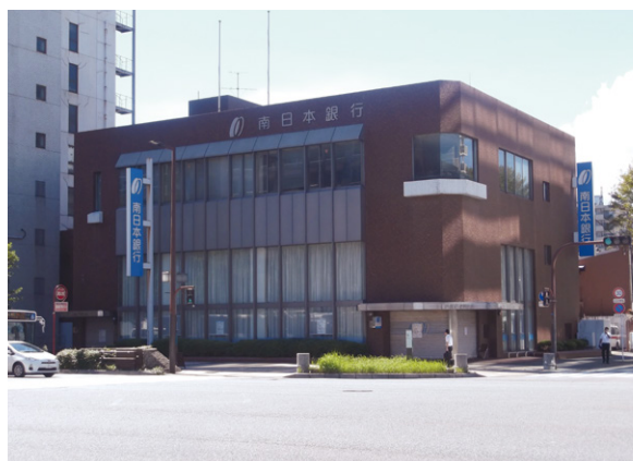
③旧・福岡支店入居建物
