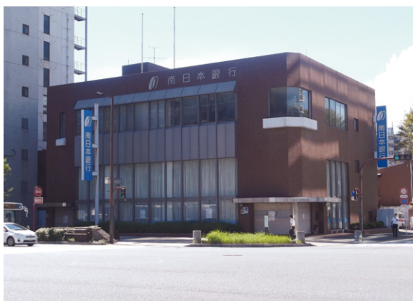
③旧・福岡支店入居建物
