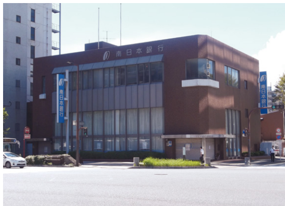
③旧・福岡支店入居建物
