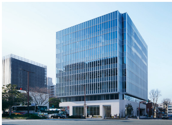
④新・福岡支店入居建物 (南日本博多ビル2階)
